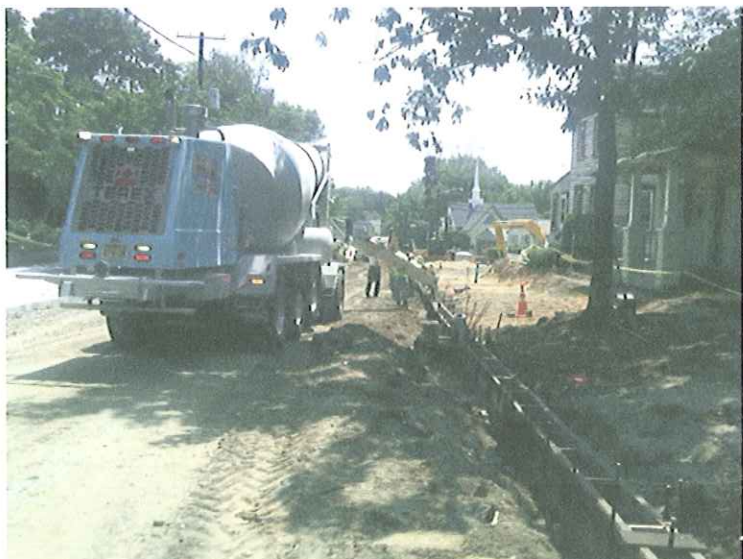
Curb Concrete Pour On Potter Street
